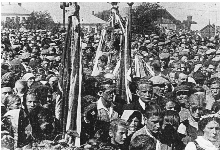
Manifestacja rocznicowa przy mogile strajkujących 7-miu zamordowanych chłopów przez policję piłsudczyków w Muninie k. Jarosławia (autor w pierwszym rzędzie)
